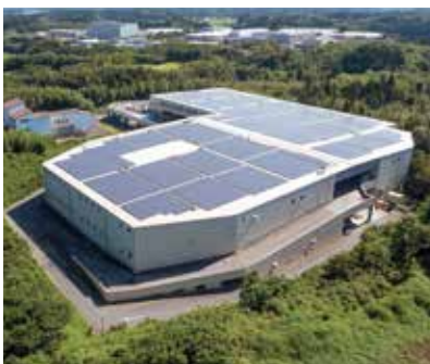
物流施設(千葉県成田市)
