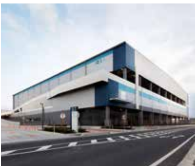
物流施設(埼玉県春日部市)
