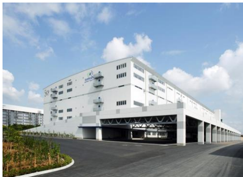
住商グローバル・ロジスティクス(株)茜浜物流センター
